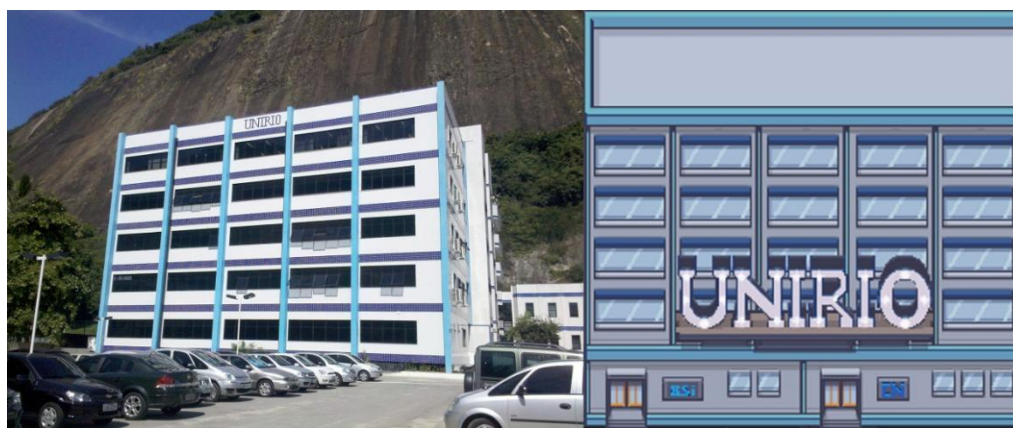
Figura 24 – Adaptação do prédio de IBIO-CCET
